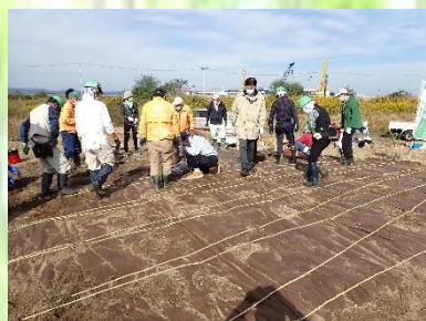
防草シート張り
